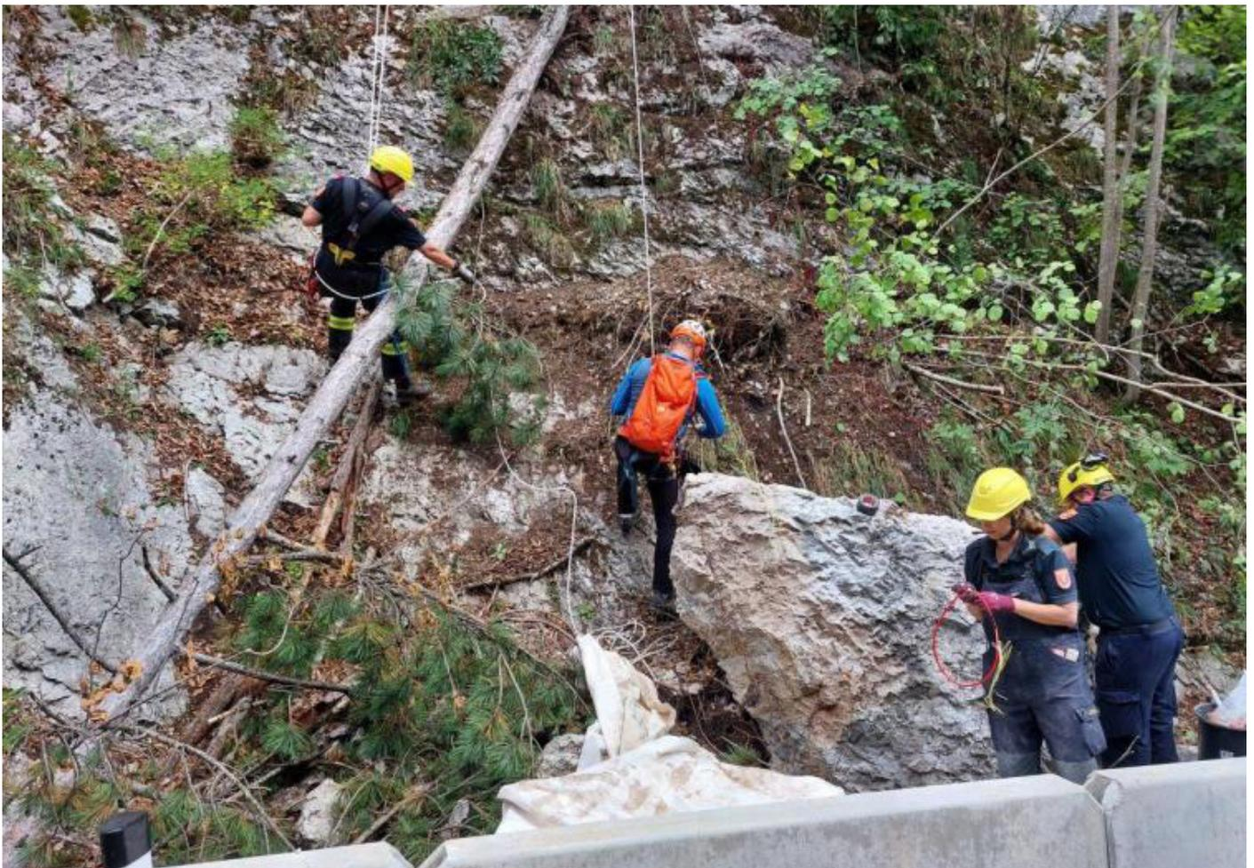
Ein aktueller Felssturz auf der L4058 war der Grund des kurzfristigen Einsatzes des Sonderdienstes Sprengdienst Viertel Süd des NÖ Landesfeuerwehrverbandes am 28. August in Muggendorf. Nach anstrengenden Vorbereitungsarbeiten in der Felswand, bei der die notwendigen Vorbereitungsmaßnahmen durchgeführt wurden, konnte schlussendlich die Sprengung erfolgreich durchgeführt werden.
